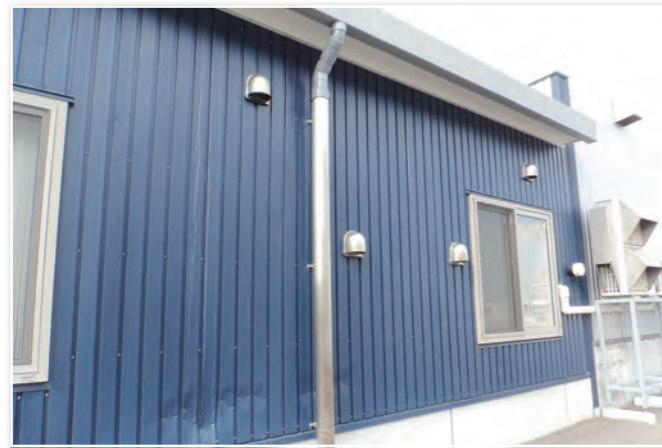
北海道石狩事務所棟(排水管長:4m)
