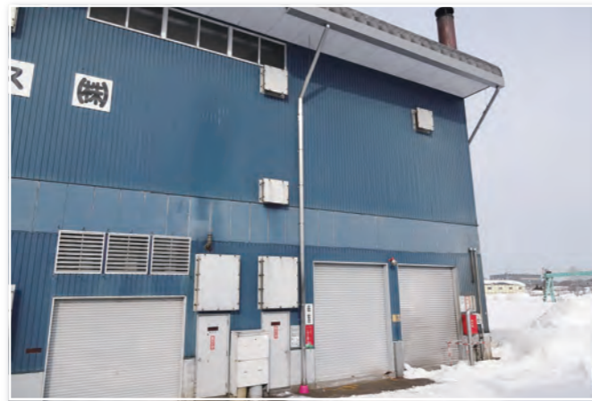
北海道石狩事務所棟(排水管長:15m)
